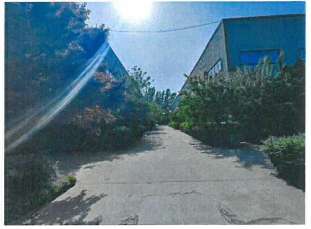
项目北侧厂房
